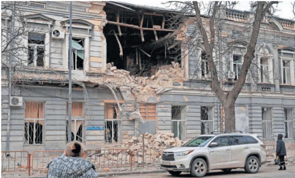
Un edificio con la fachada parcialmente destruida por un dron ruso, ayer en la ciudad de Odesa, en el sur de Ucrania. NINA LIASHONOK (REUTERS)
